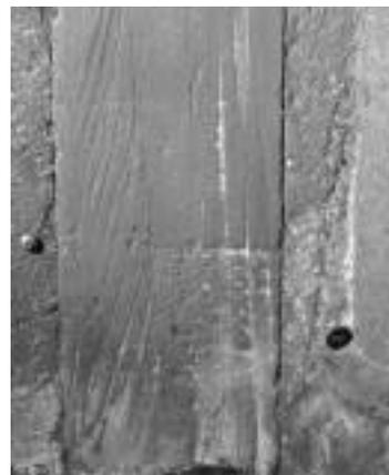
Foto 2: Durch das Absanden treten die Sedimentstrukturen des Sandsteins deutlich hervor. Bildbreite ca. 80cm.
